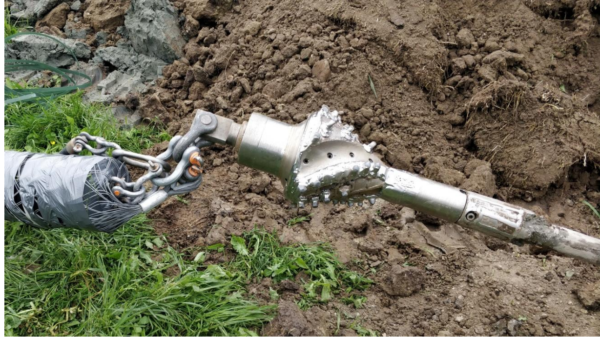
Grabenlose Verlegung im günstigen Spülbohrverfahren
