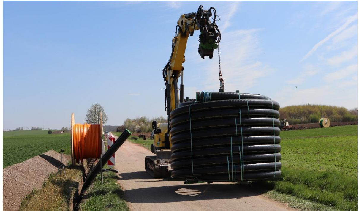
Grabenfräse + Verlegung der Wärmerohre
