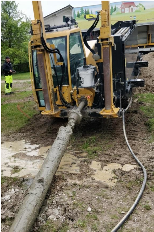
Grabenlose Verlegung im günstigen Spülbohrverfahren
