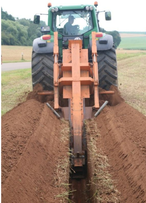
Grabenfräse + Verlegung der Wärmerohre
